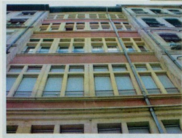
Façade du Quai Saint Antoine
